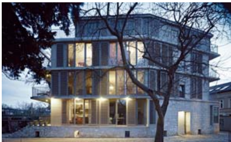
Die bewegte Fassade bietet durch Fensterläden mit Eichenholz-Lamellen je nach Bedarf Sichtschutz, Verschattung oder Transparenz.
