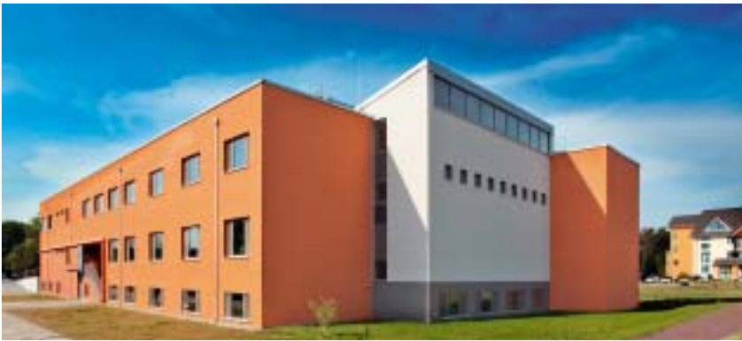
Die Anordnung der Alu-Holzfenster unterstützt die homogenen, durchlaufenden Fassadenoberflächen.
