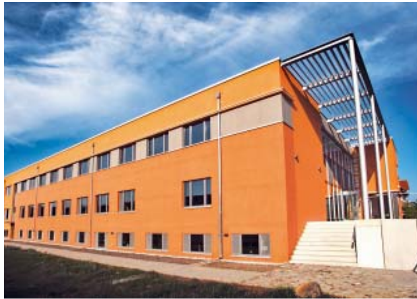
Die Fassadengestaltung lehnt sich an die ziegelroten Solitärbauten des historischen Campus an.
